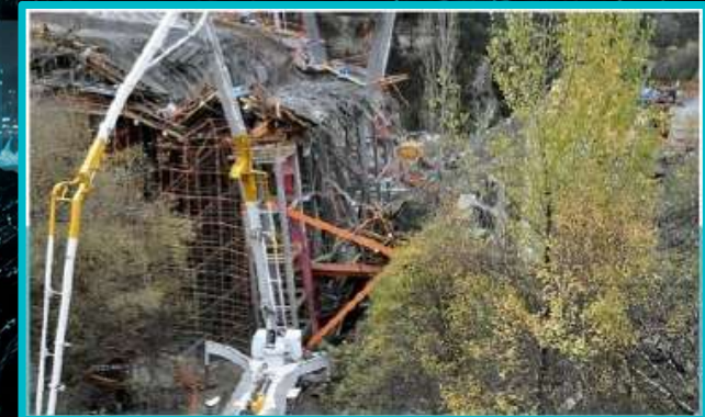
Beispiel: Genua, Italy Brückeneinsturz, August 2018
